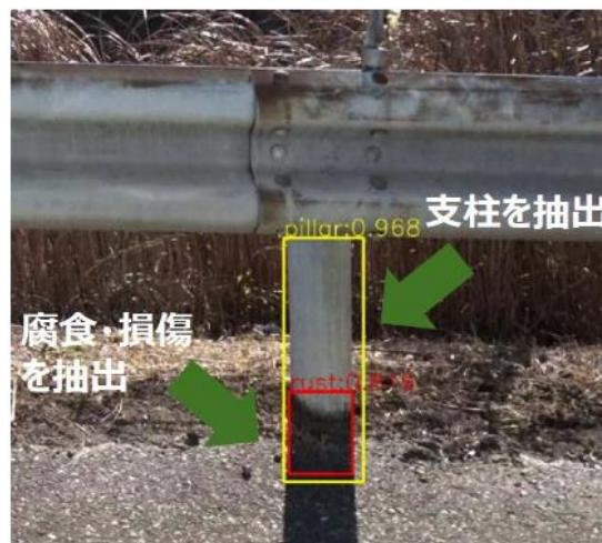
検出した腐食・損傷個所を位置情報で管理
